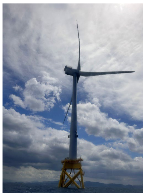
(b) 9.6 MW 級着床式洋上風車
