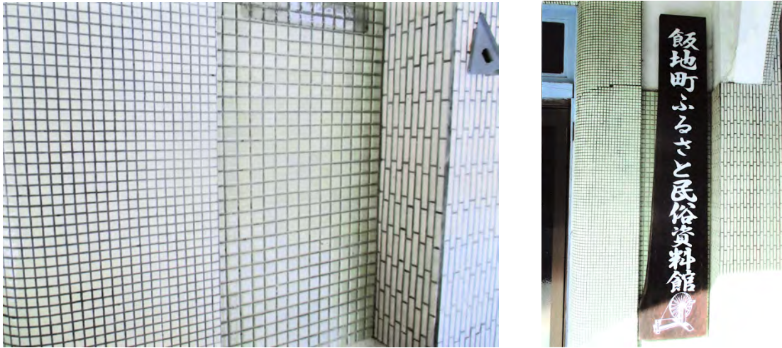
図2. タイル貼りの外壁
