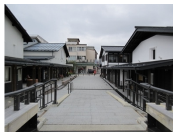
図9. 本町商店街からみた行神橋
