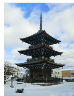
図 23. 飛騨国分寺三重塔 (岐阜県重要文化財)
