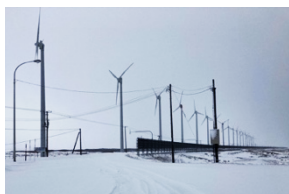
図 8. サロバツ原野の風力発電所
