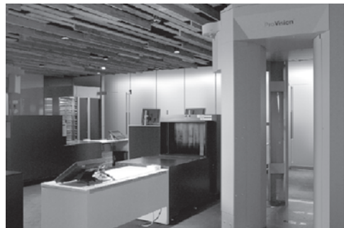
図表3. セキュリティ設備
