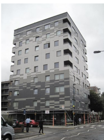
写真2 CLTによる9階建て集合住宅
