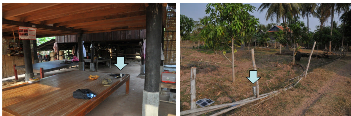
図 3 定点観測機器の設置状況 (左: 高床式住居の 1 階 右: 農地)
