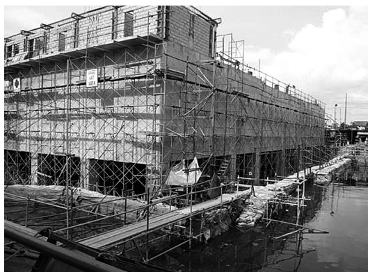
Photo 1 建設中のマニラの集中下水処理場
