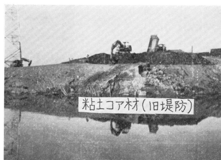
図-8 決壊堤防の粘土コア材(旧堤防)
