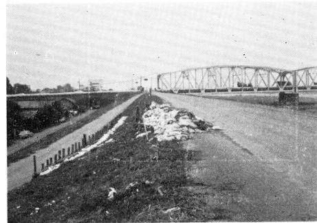
(b) 取り付け道路のり面の被災
