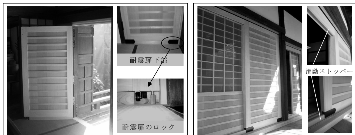
写真 4. 耐震框戸／扉の開閉の仕組みと活動拘束要素
