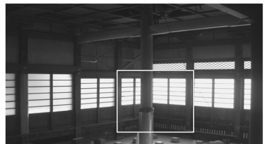
写真 1. 可採光耐震戸設置予定箇所 (浄土真宗再来寺本堂改修一名古屋市)
