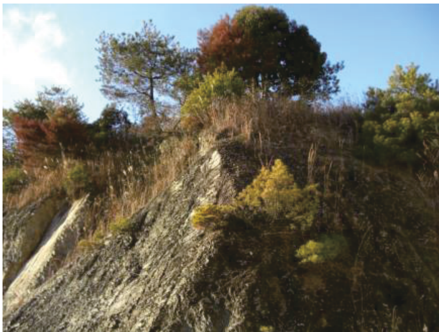
写真 4-1. 岩盤振動計測箇所
